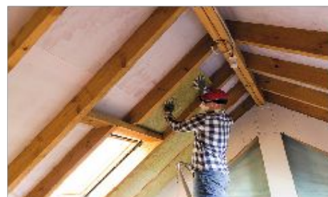
Dakisolatie binnenzijde
