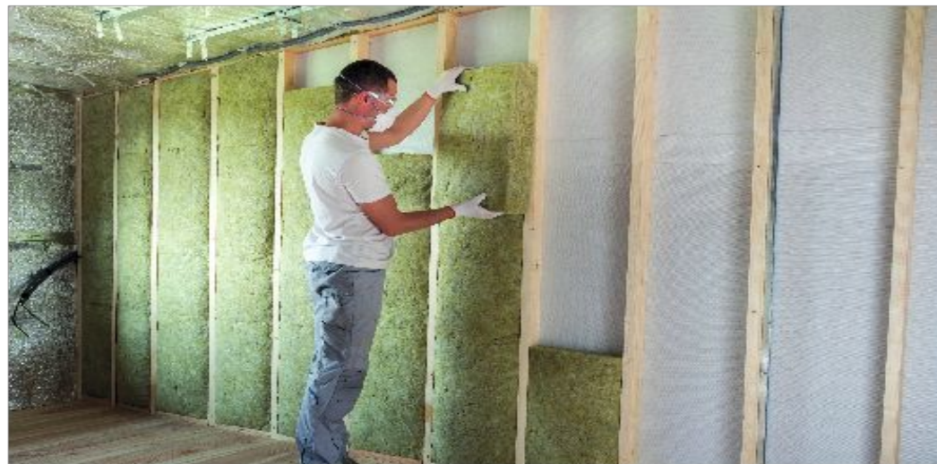
Gevelisolatie met voorzetwand
