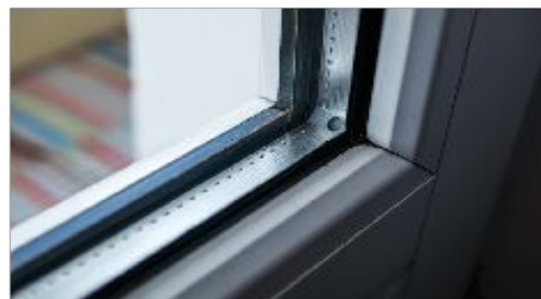
HR++ glas in bestaand kozijn
