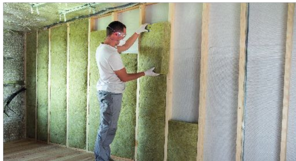
Gevelisolatie met voorzetwand
