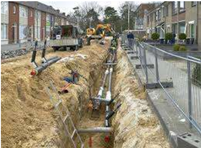
Warmtenet in de straat
